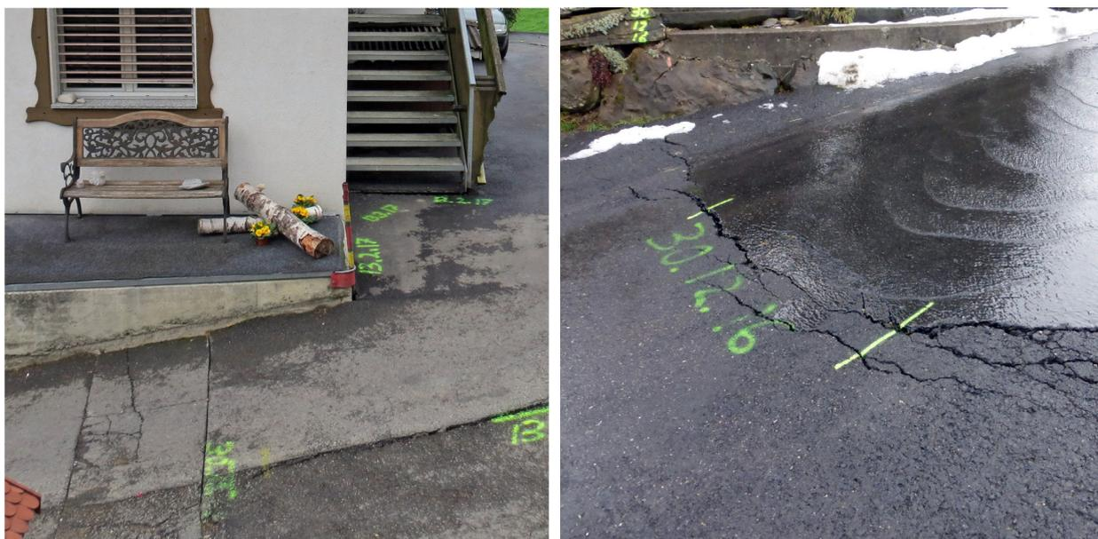
**Figur 2: Frische Setzung des Geländes bei Gebäuden und Risse im Belag deuten auf aktive Rutschung hin**
